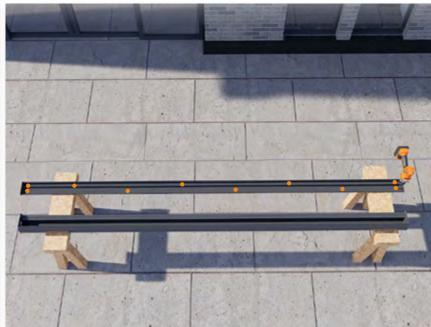
Platzieren Sie die Wandplatte auf der richtigen Höhe und stellen Sie sicher, dass sie waagerecht ist.
