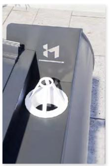
Setzen Sie einen Zierclip an die Wandplatte und an die Rinne. Platzieren Sie dann einen Träger und anschließend wieder einen Zierclip. Wiederholen Sie dies, bis Sie den Bereich erreichen, in dem Ihre Stromanschluss liegt.
